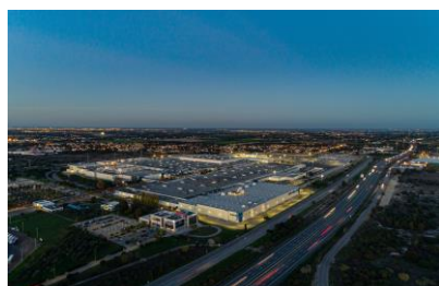
Vista panorâmica da fábrica de Palmela
